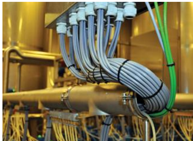
Alle kabler er skiftet til de mere end 2.000 ventiler på blanderiet.
