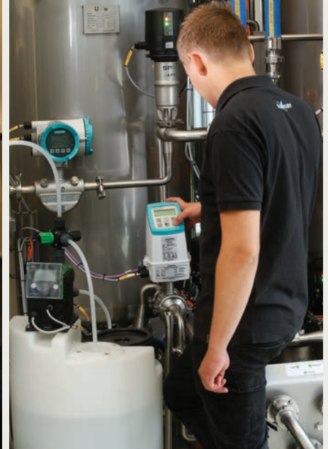
Mikkel Bundgaard er i færd med at styre en produkt-overførsel ved hjælp af Sitrans FM flowmåler.
