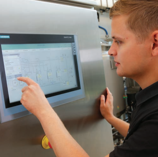
Testmejeriets CIP-anlæg styres via en touchscreen.
