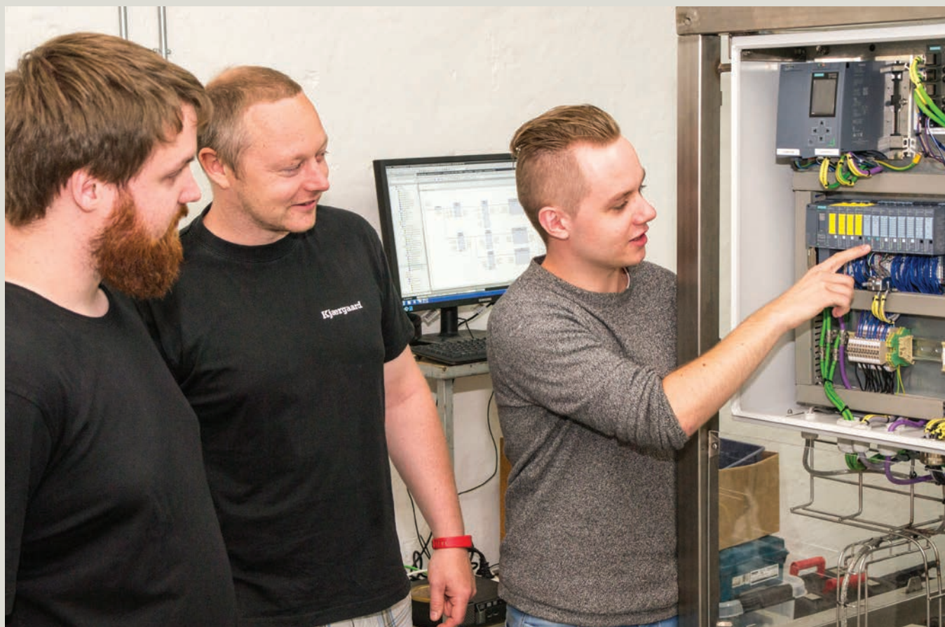
Simon fortæller om anlæggets styring, der er programmeret med TIA-portalen V14.
